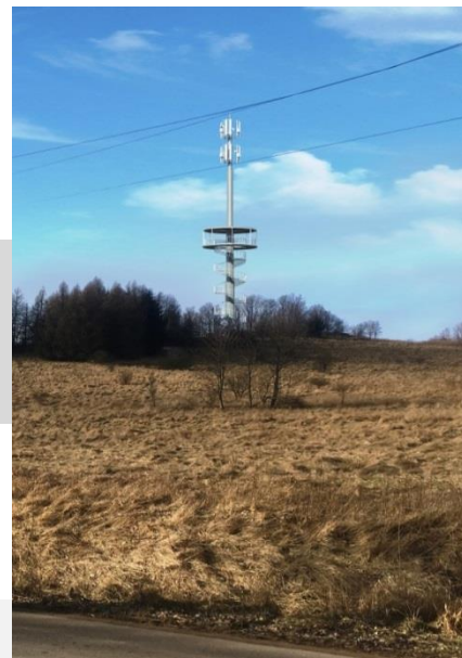
Emitel – wieża widokowa z funkcją telekomunikacyjną
