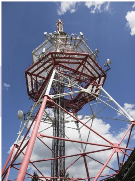
Emitel – 1 wieża dla 4 operatorów
