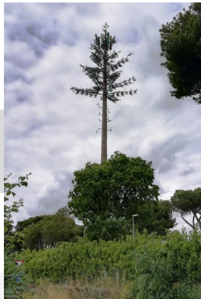
Rzym – imitacja drzewa z funkcją nadajnika komórkowego
